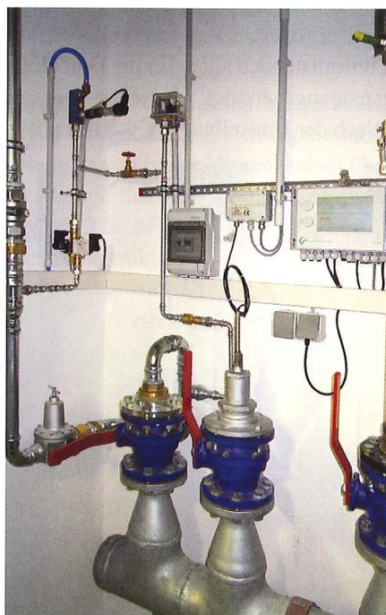
Über insgesamt vier 3,5-Zoll-Leitungen gelangt die Druckluft in die einzelnen Abteilungen des Unternehmens. Über vier integrierte Messgeräte wird der jeweilige Verbrauch ermittelt. Der Wochenendmodus beginnt nach der letzten Schicht am Freitag. Der reguläre Zulauf zum Verteiler wird dann über eine Zeitschaltuhr gesperrt, und die Druckluft fließt über einen Bypass und einen Regler mit derzeit 4 bar ins Netz.
