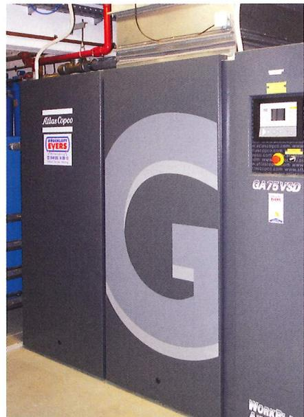
Ein drehzahl geregelter, öleingespritzter Schraubenkompressor GA 75 VSD sowie zwei GA 45+ mit fester Drehzahl von Atlas Copco stellen heute die bedarfsgerechte Druckluftversorgung sicher.
