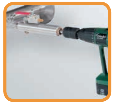
Anbohren unter Druck
