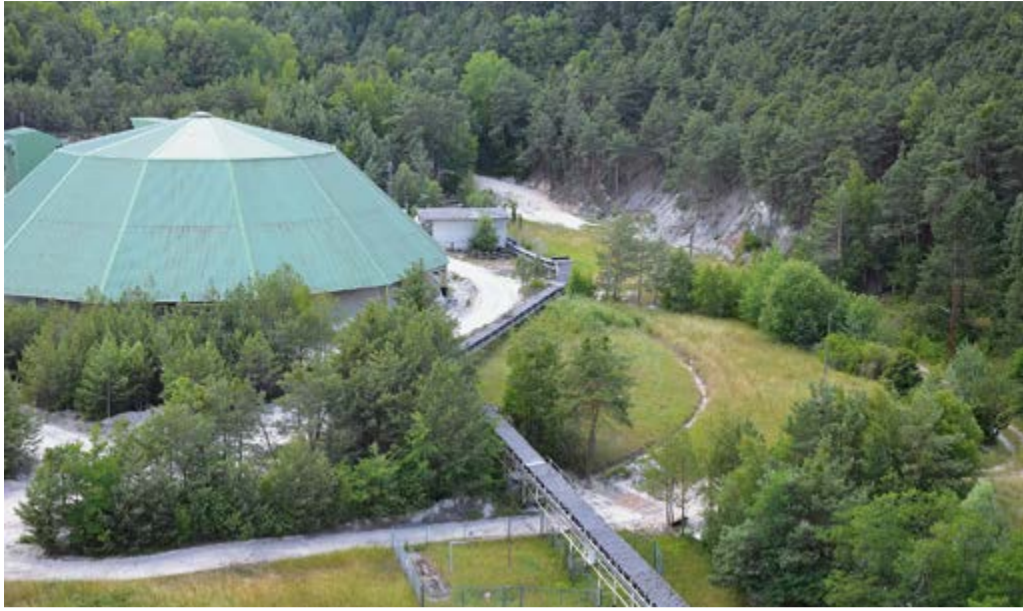
Die Rundlagerhalle der EKW GmbH. Hier im nordpfälzischen Eisenberg befindet sich eines der größten Klebsand-Vorkommen Europas.
