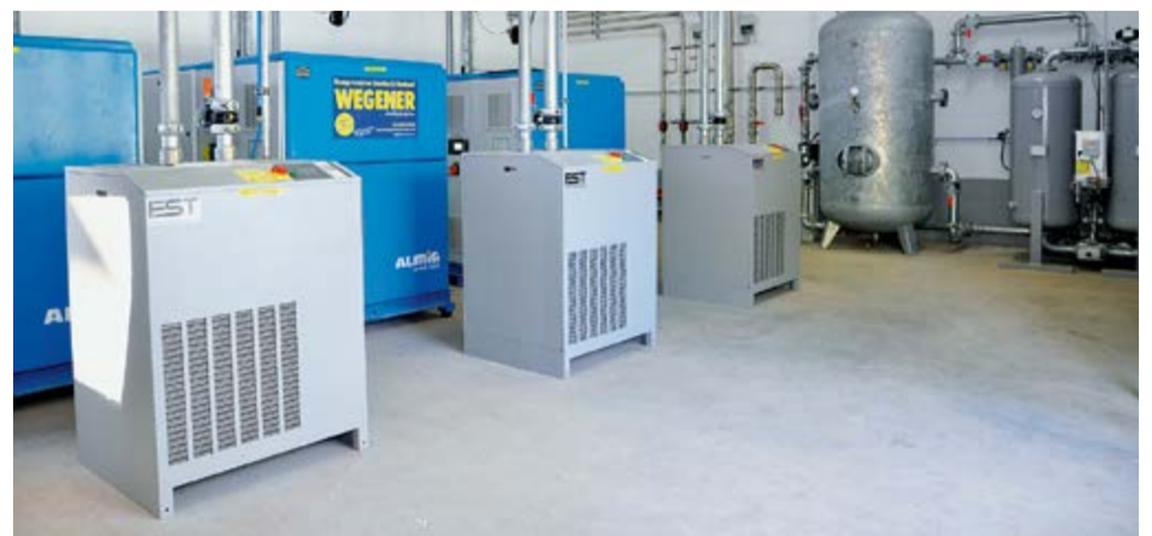
Die drei direktgetriebenen, drehzahlregelten Schraubenkompressoren. Diese passen sich an permanente Lastwechsel an und vermeiden somit kostenintensive Leerlaufzeiten. Nachgeschaltet die Aufbereitung mit Vor- und Nachfilter, Druckluftkältetrockner und Adsorptionstrockner.
