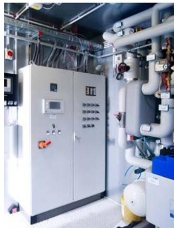
Gesamtsituation wurde vom Energieberater und Projektleiter der GROSS GmbH, Andreas Platt, ein Konzept erstellt, welches eine maximal wirtschaftliche und platzsparende Neuinstallation mit einer frequenzgeregelten Druckluffterzeugungsanlage vorsah – integriert in eine vollausgestattete GROSS-Airbox®.
